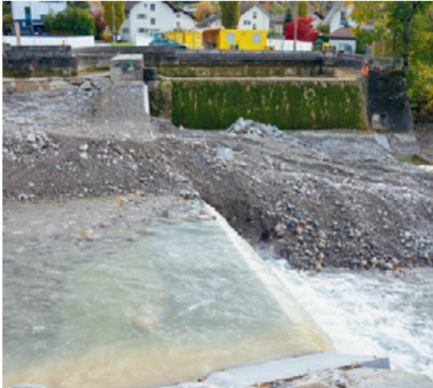
Bereit fliesst das Zulgwasser über die abgesenkte Müllerschelle.
