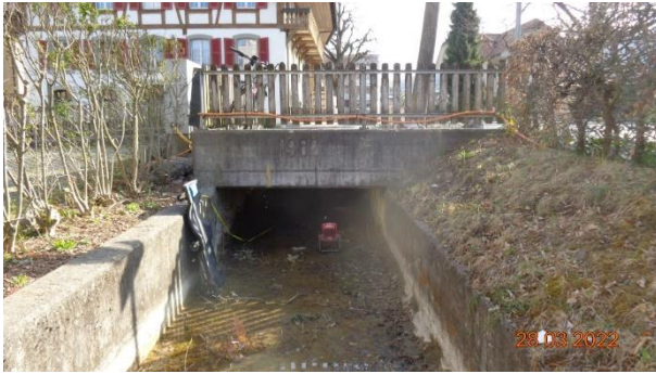
Abbildung 1, Durchlass Mühlebach unter der Erlenstrasse
