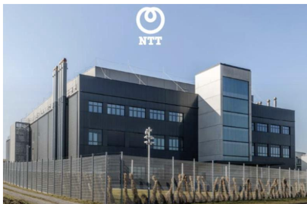
Abb: Rechenzentrum NTT in Rümlang
