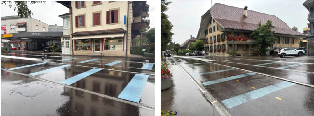
Münsingen: Kantonsstrasse durchs Dorfzentrum, blaue Querungszonen
