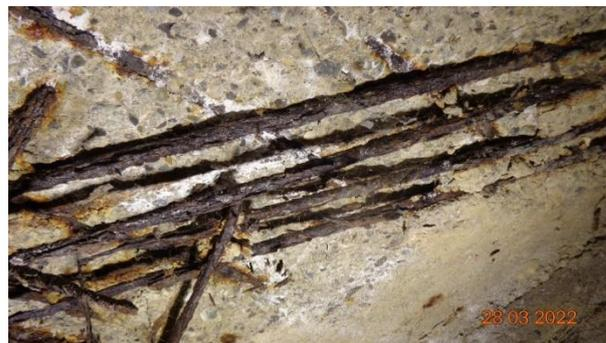
Abbildung 4, Betonabplatzungen und freiliegende Armierung
