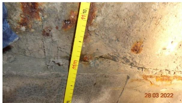
Abbildung 2, Betonabplatzungen mit Korrosionsspuren
