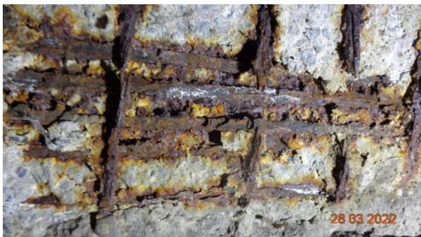
Abbildung 3, freiliegende und durchgerostete Armierung
