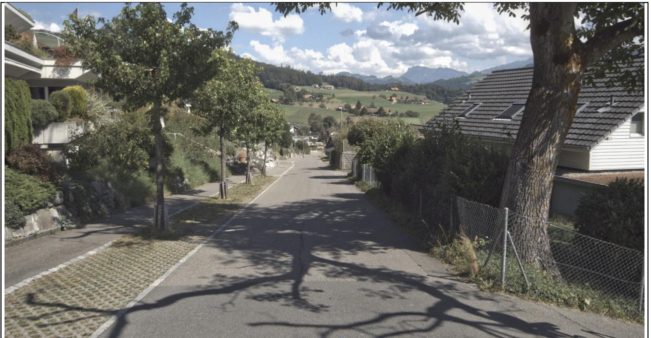
Abbildung 7; Beispiel Strassenquerschnitt mit 4.50m Fahrbahnbreite
