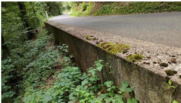
Rückverankerte Stützkonstruktion am Sonnenrainweg
