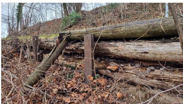
Abbildung 4: Zustand talseitige Hangsicherung
