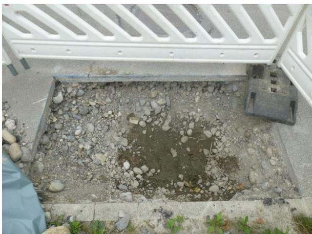
Abbildung 3: Sondage Schönmatweg, Foundationsschicht max. 30 cm
