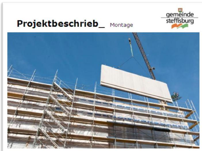
...sowie anschliessend mit dem Kran versetzt und montiert.
