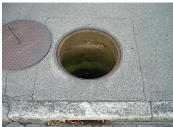
Abbildung 6: Schadhafter Schlammsammler
