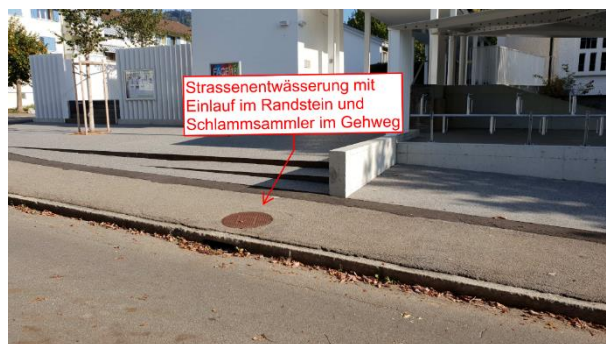
Abbildung 3: Beispiel bestehende Strassenentwässerung
