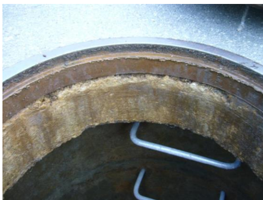
Abbildung 7: Schadhafte Kontrollschachtabdeckung
