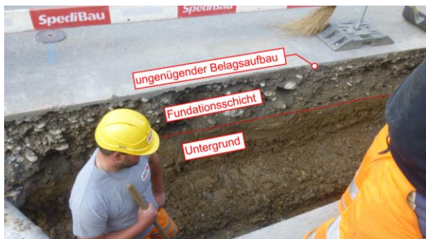
Abbildung 2: Bestehender Aufbau Kirchfeldstrasse
