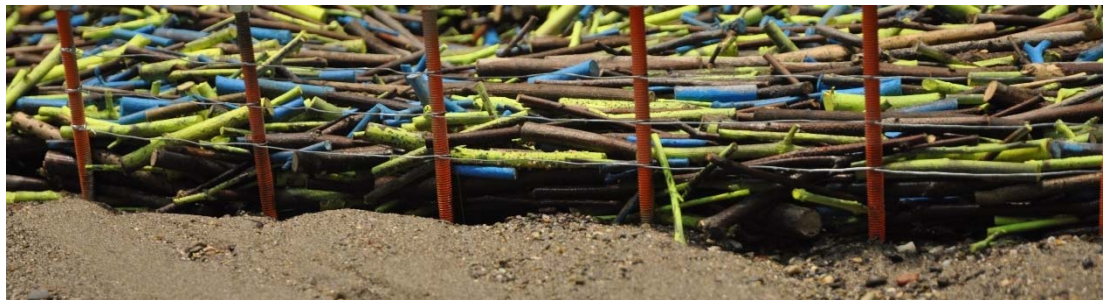
Abb. 7-17: Rechensystem mit einem Stababstand von 5 m sowie drei quer gespannten Stahlseilen.
