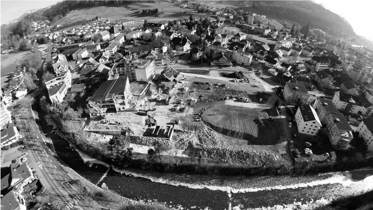
Gschwendareal im Abbruch
