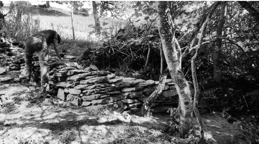
Trockenmauer erhält vom Förster noch den letzten Schliff
