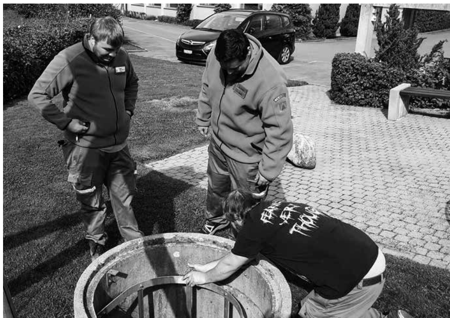
Fachgerechte Montage der Ausstiegshilfe
