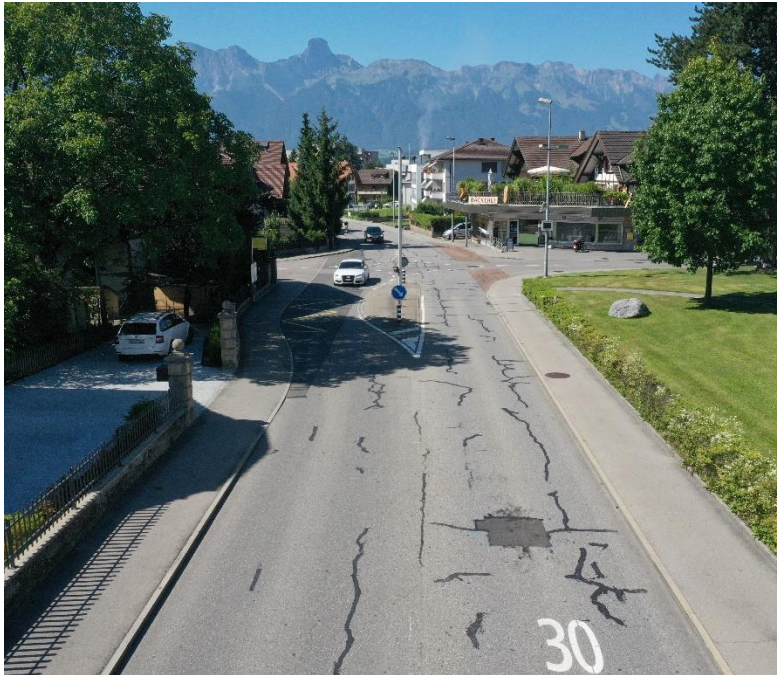
Abbildung 5: Belagsschäden Schwäbisstrasse
