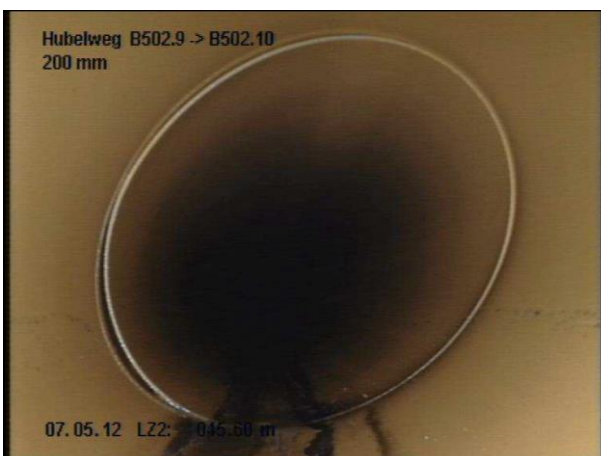
Deformierte Abwasserleitung
