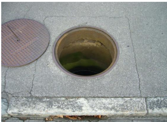
Abbildung 6: Schadhafter Schlamm-sammler
