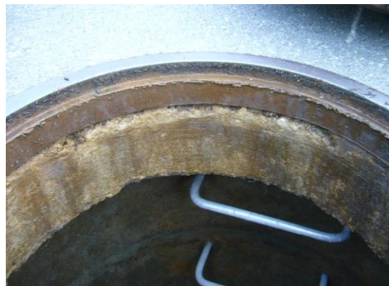
Abbildung 7: Schadhafte Kontrollschacht-abdeckung
