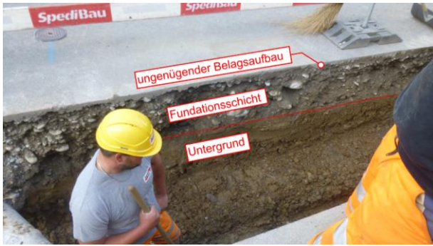
Abbildung 2: Bestehender Aufbau Kirchfeldstrasse
