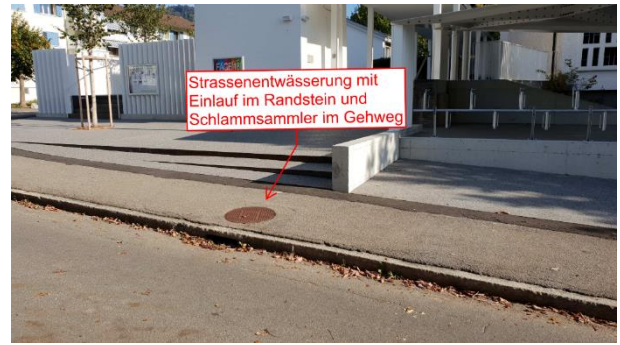
Abbildung 3: Beispiel bestehende Strassenentwässerung
