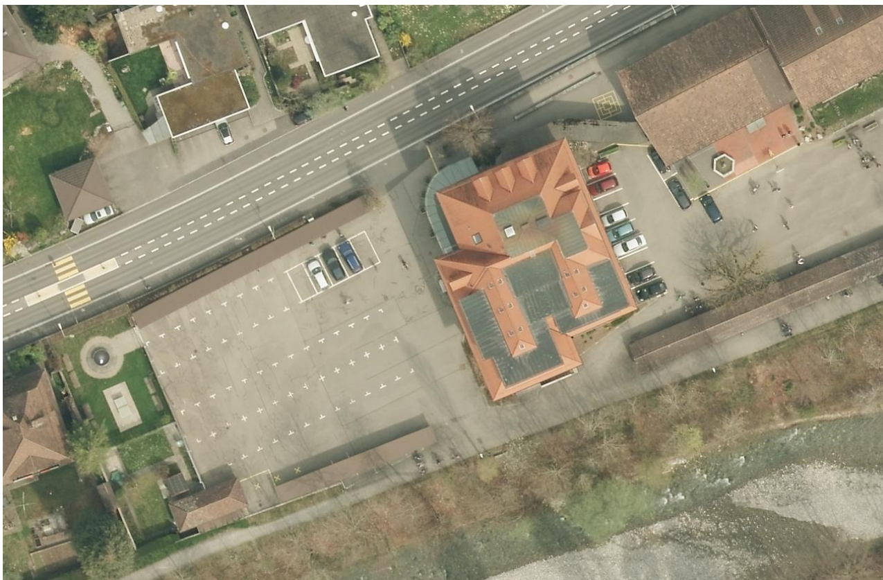
Orthofoto Schulanlage Zulg Altbau/Singsaal
