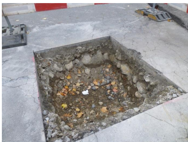
Abbildung 2; Sondage Merkurstrasse: Steinbett mit Schottertränkung und Feinbelag
