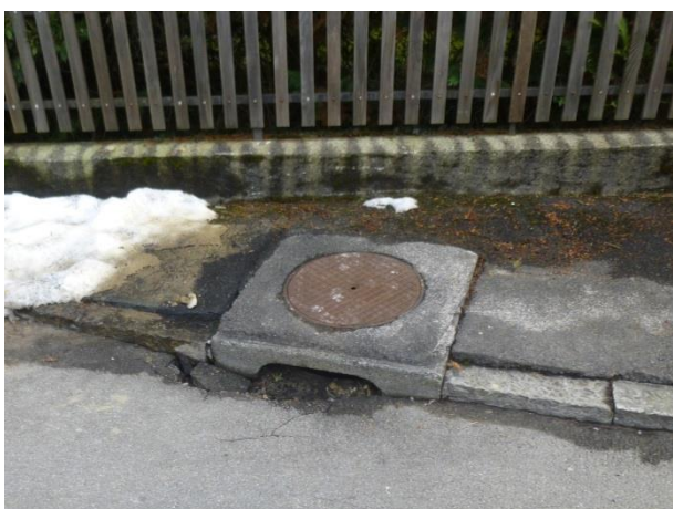
Abbildung 10; Schadhafter Schlammsammler mit Schlucköffnung im Randabschluss
