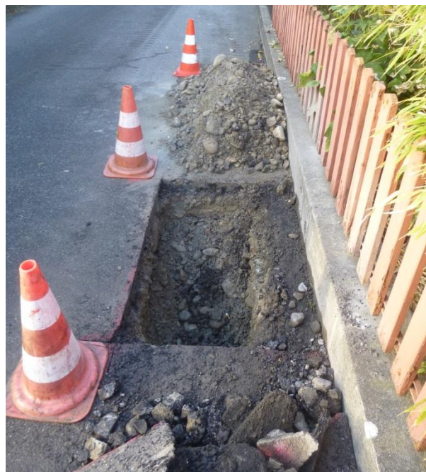
Abbildung 3; Sondage Hasenweg nord; Kiessand mit zweischichtigem Belagsaufbau
