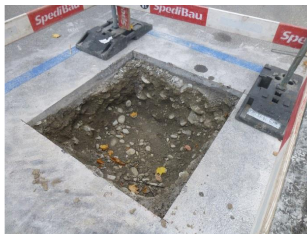
Abbildung 3; Sondage Merkurstrasse; Fundationsschicht Kiessand mit zweischichtigem Belagsaufbau
