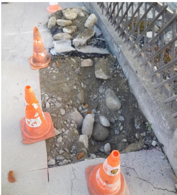
Abbildung 2; Sondage Hasenweg süd: Steinbett mit Schottertränkung und Feinbelag
